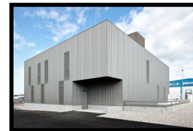
EMPRESA INSTALADORA HABILITADA
