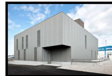
EMPRESA INSTALADORA HABILITADA
