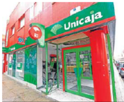
La oficina de Unicaja de la avenida Olivar de Rivero.
